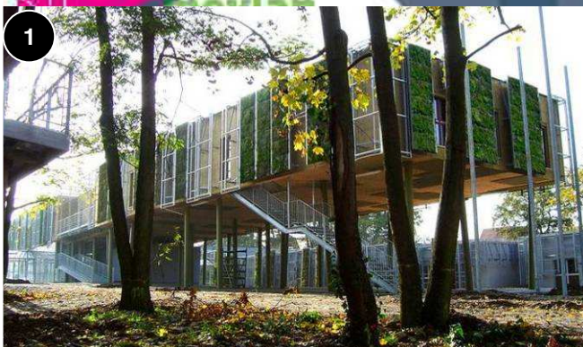
Bâtiment sur pilotis Sociopolis
