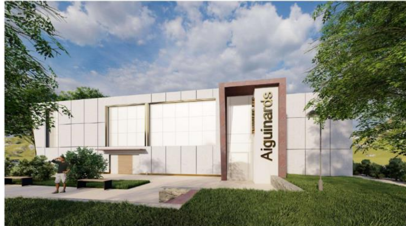
Le futur Gymnase des Aiguinards
