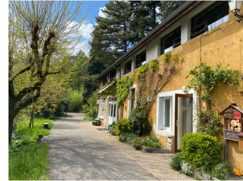
Rénovation du CINE
