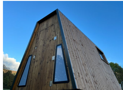
Toilettes du Parc du Bruchet
