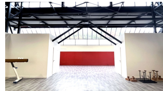
Mise en conformité du gymnase des Buclos
