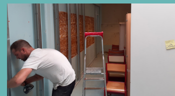
Pose de store et ventilation
