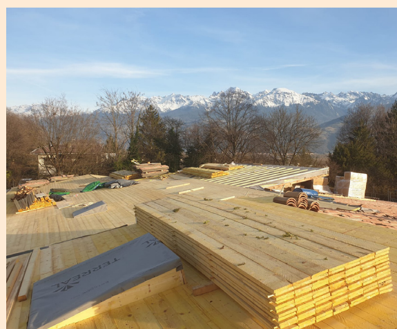
La réfection de la toiture de l'école maternelle du Haut-Meylan avance à grand pas.
